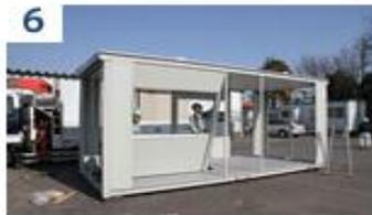
6 システム化された壁面パネルを取り付けます。
