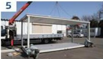
5 屋根・柱・床をボルトで固定し、躯体の完成です。
